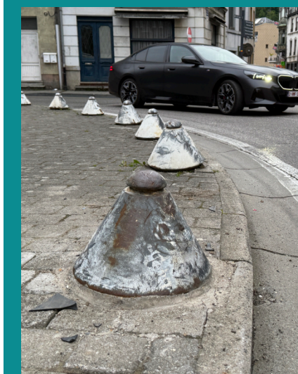
Le virage au carrefour du boulevard des Anglais et de la rue Entre-les-Ponts
