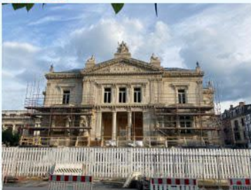
Les Anciens Thermes en travaux
